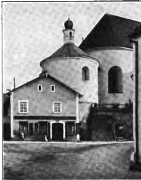
Fig. 113. Roding. Ansicht der ehem. Friedhofskapelle.
